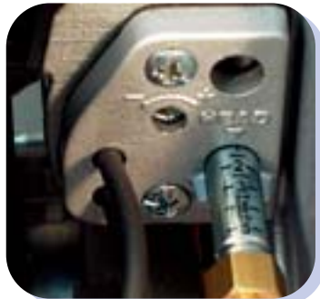
Setting combustion head Regolazione testa di combustione
