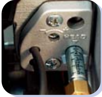
Setting combustion head Regolazione testa di combustione
